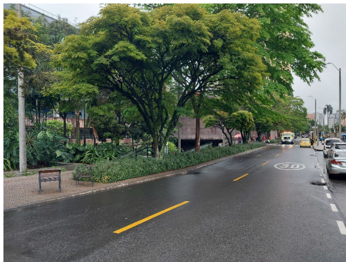
Imagen 9: Carrera 54 - Primera calle pavimentada con material reciclado de la ciudad de Medellín.
